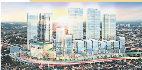
进行中的项目包括柏威年白沙罗高原（Pavilion Damansara Heights）的空调与通风系统工程。
